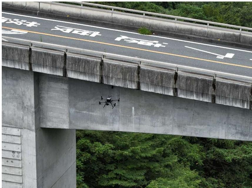
写真3 UAV 橋梁点検状況
